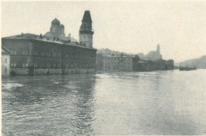
Blick auf das Passauer Rathaus. Erdgeschoß ist ganz im Wasser versunken.
