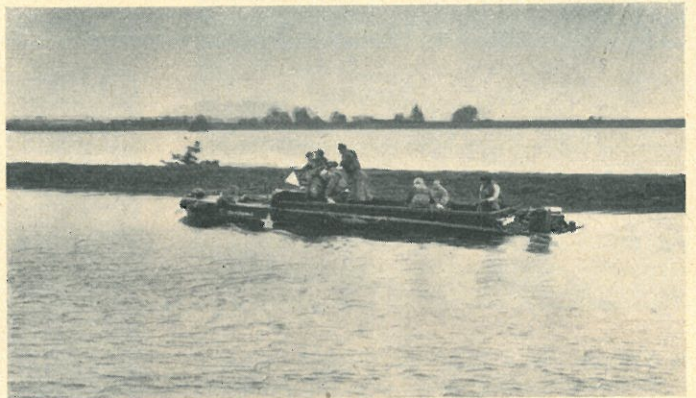
Am Bogenbach bei Deggendorf. Ein Amphibienfahrzeug schleppt Sandsäcke an schwer zugängliche Stellen des Dammes, eine Hilfsaktion, die wesentlich zur Erhaltung der Dämme beigetragen hat. Die schwere Ladung ist aus dem starken Tiefgang des Fahrzeugs zu erkennen.
