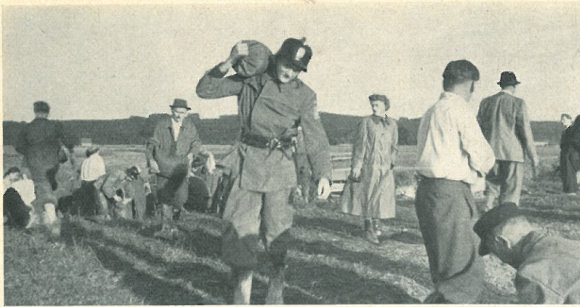
Sandsackschleppen war auch für die Feuerwehrmänner in den Tagen des Hochwassers groß geschrieben. Das Bild zeigt einen Angehörigen der Freiwilligen Feuerwehren im Landkreis Landshut, die in großer Zahl die FF Landshut in den Arbeiten an den Isardämmen unterstützten.
