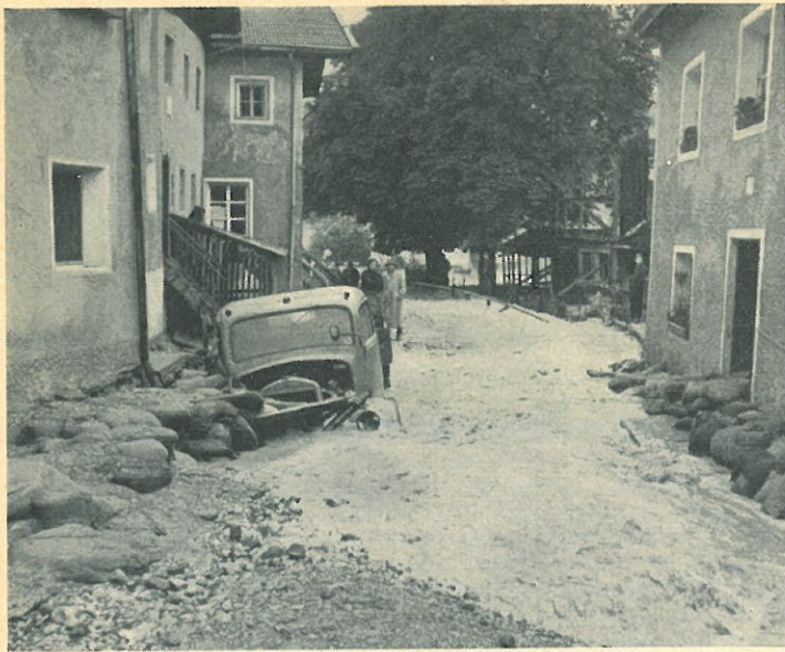
Die Gerbergasse in Tittmoning, die vom Überwasser eines Stadtgrabens in einen reißenden Sturzbach verwandelt wurde. Ein parkender Lastkraftwagen wurde überrascht und in wenigen Minuten total verschlammt.
